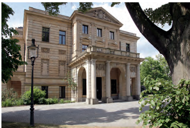
Villa Mumm, zentrale Dienststelle des Bundesamts für Kartographie und Geodäsie (BKG) in Frankfurt am Main
