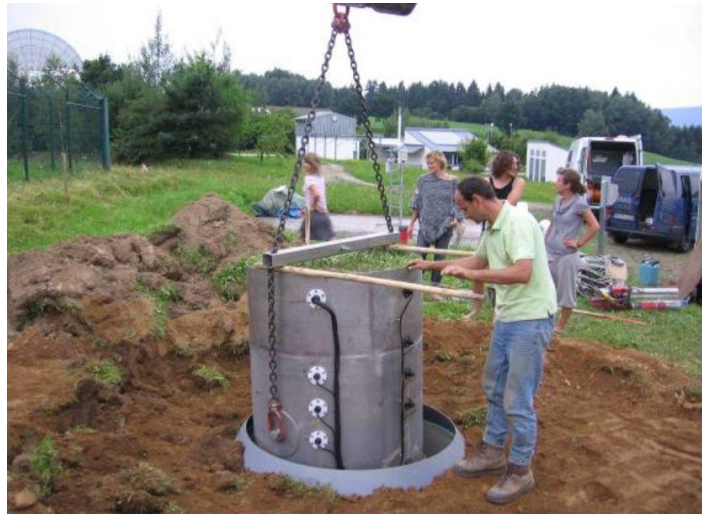
Abbildung 2.10: Einbau eines Lysimeters im Juli 2008
