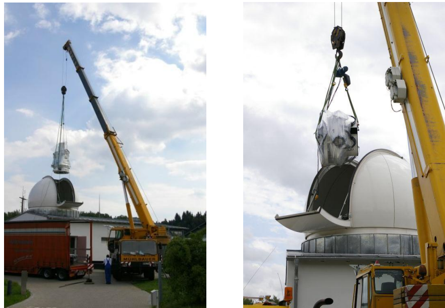
Abbildung 2.3: Installation des neuen SOS-W Teleskops im Juli 2008
