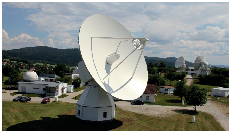
Bild 1: Geodätisches Observatorium Wettzell mit 20-m Radioteleskop im Vordergrund, den beiden 13-m TWIN-Teleskopen rechts im Hintergrund und der Kuppel des Laserentfernungsmesssystems SOS-W (links)
