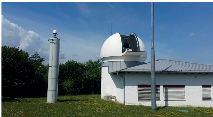
Bild 3: Laserentfernungsmesssystem WLRs mit Betriebsgebäude und Kombinationstarget (links)
