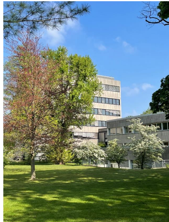
Abbildung 3: Gebäude B und C im Frühling
