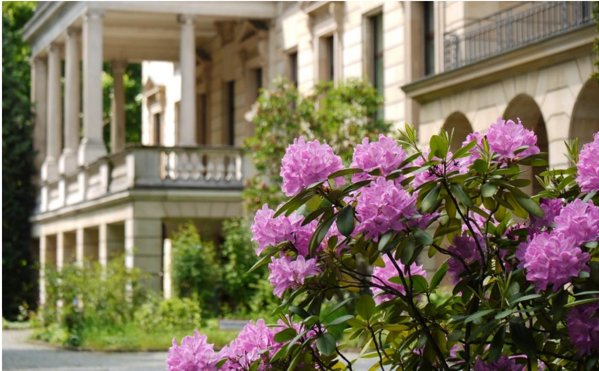
Abbildung 3: Detailaufnahme der Villa Mumm
